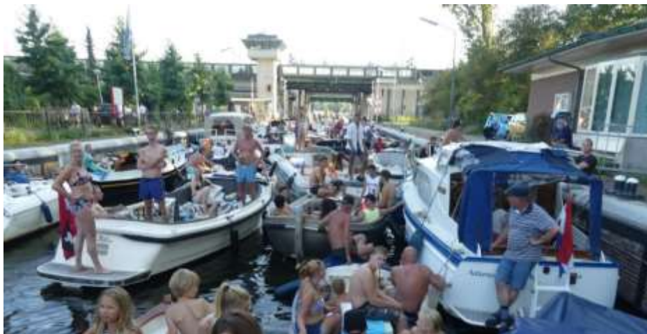
De Nieuwe Meer sluis in Amsterdam, deel van de 'Staande Mast route'. Weekenddag in augustus 2019, ca. 60 sloepen BRTN-categorie E en F en 2 DM-klasse motorboten in één schutting (ca. 2 volle schuttingen per uur). Waternet is bezig het schutproces te optimaliseren.
